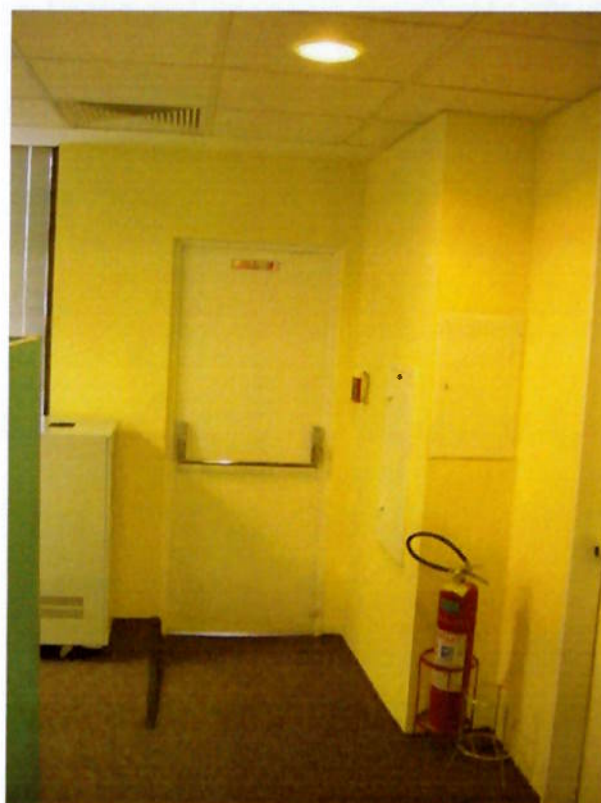
Figura 15 — Detalhe da Saída de Emergência com Barra Antipânico
